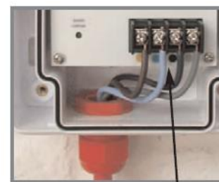
ترمینال های سیم بندی کنترلر به دتکتور با استفاده از کدهای رنگی
